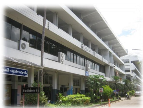
อาคาร 3 อาคารลีลาวดี
